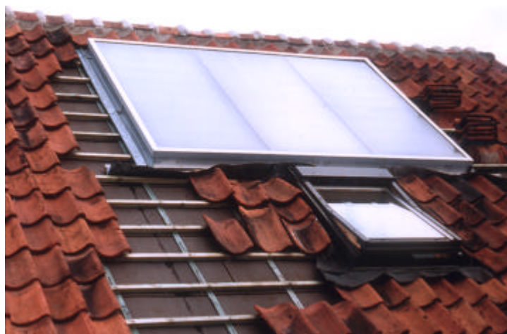
intégré au toit: détail pendant le placement
