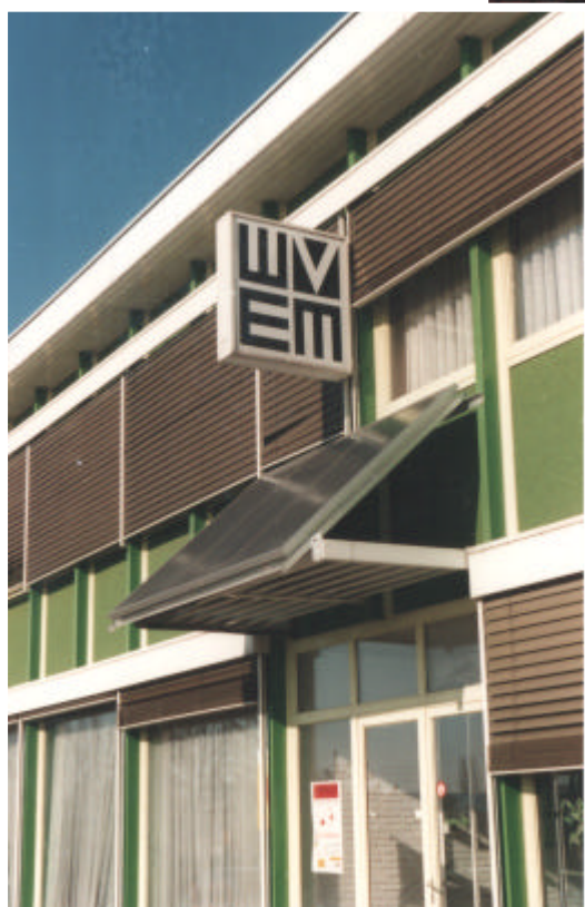
châssis de façade au-dessus de l'entrée
